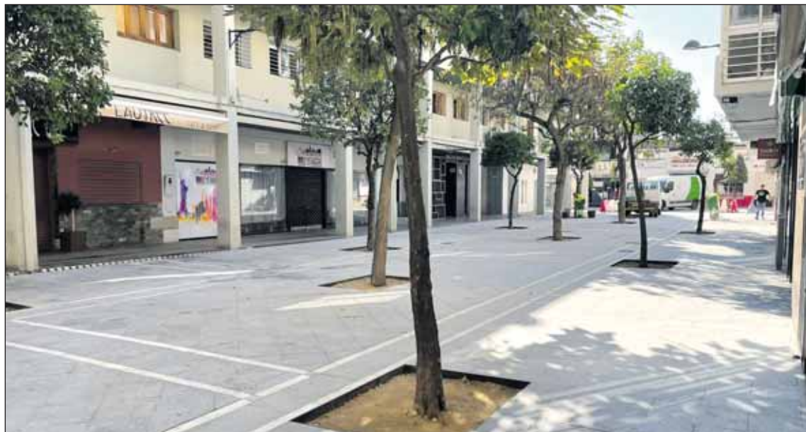
Finalizan las obras de reurbanización en la plaza Virgen de la Soledad ('El Llano').
