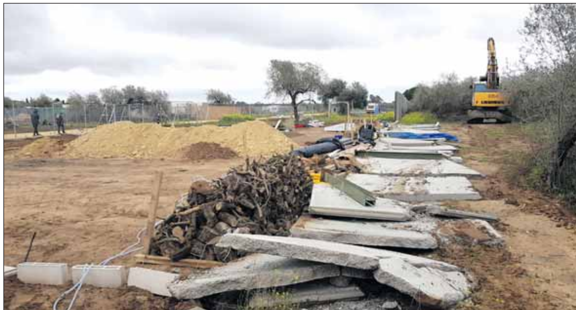
Demolición de una parcelación ilegal en la finca de San Juan del Hornillo.
