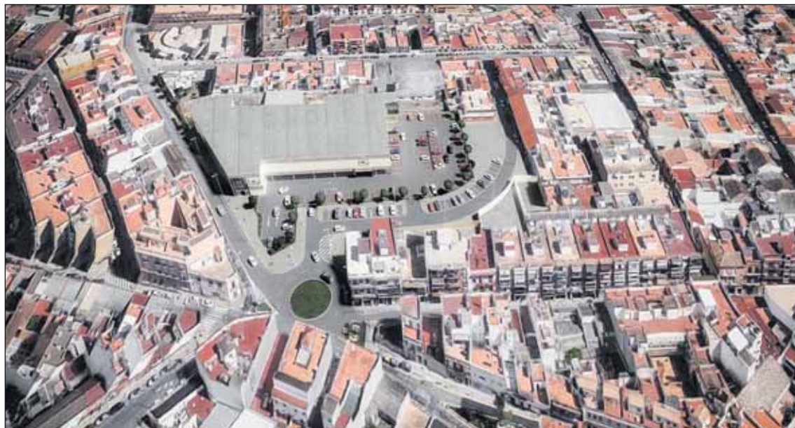
Imagen renovada para la céntrica zona de Isaac Peral y Sta. M a Magdalena.
