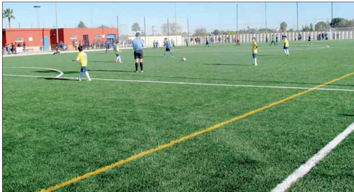
Se culminará la instalación de césped artificial en el campo de Fuente del Rey
