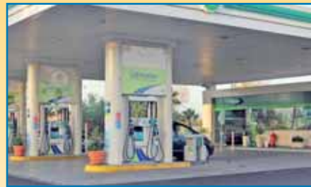
Gasolinera BP Galises Glorieta País Vasco, S/N
