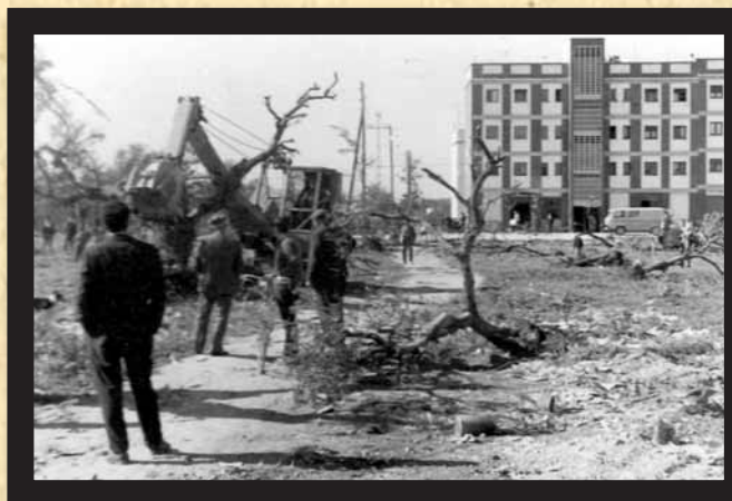
1962. Las máquinas proceden al derribo de árboles para abrir la nueva calle Carlos I, que unirá el núcleo urbano con la calle Letamendi (Los Pirralos). Al fondo, los nuevos pisos de San Pablo.
